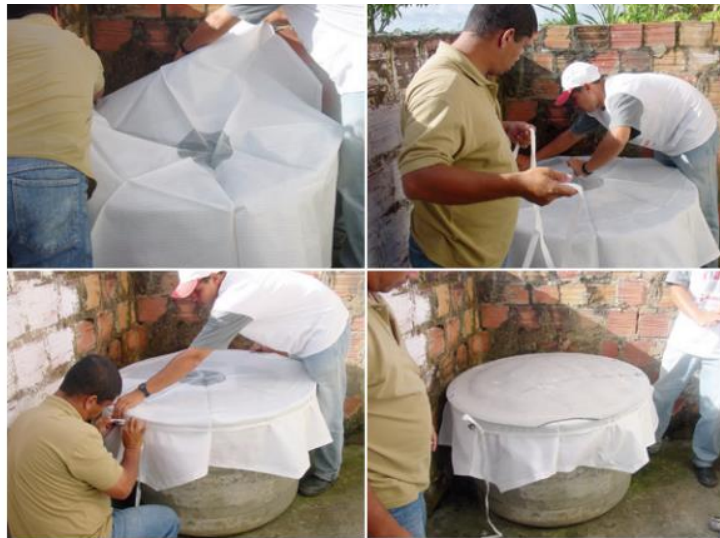
Figura 4 - Uso de capas para vedação de depósito de água.
